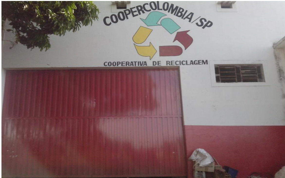
Figura 38 : Local de armazenamento de Resíduos Recicláveis situada na rua São Paulo n. 426 .
