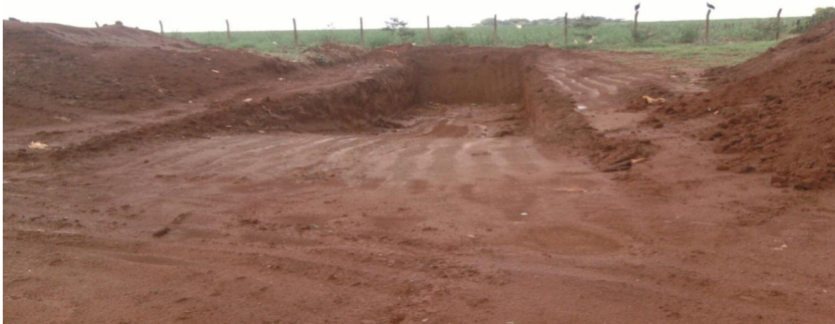
Figura 9 – Foto de Valas abertas no interior do Aterro Sanitário Municipal.
